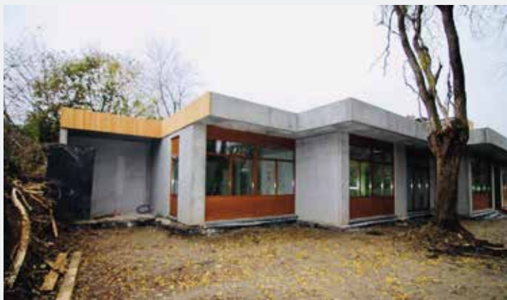
Travaux des Piloux : début 2021
