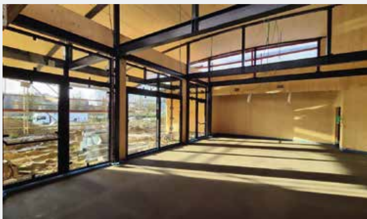
Travaux du CREB Anderlecht - début 2021
