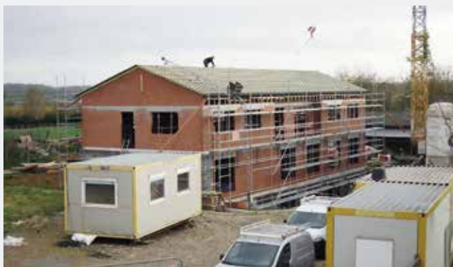
Travaux de la Toûne – Début 2021
