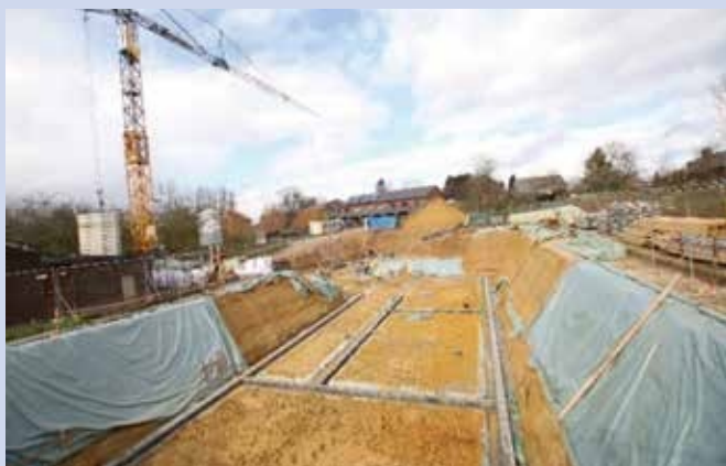
Chantier de la Toune en février 2020
